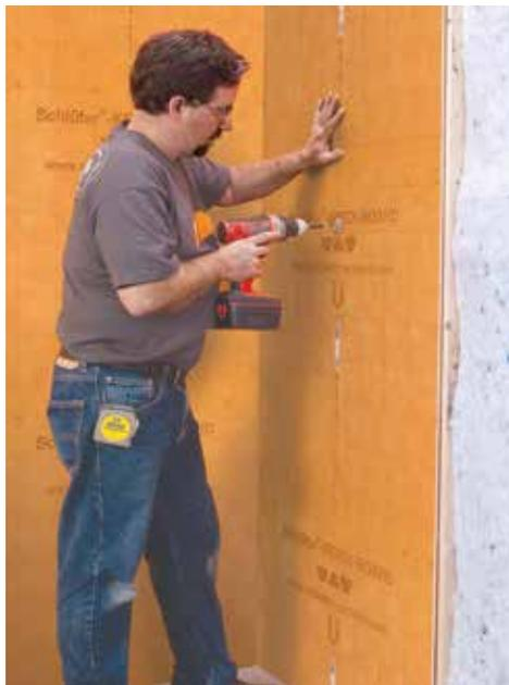
supplémentaire est offert si nécessaire. Sur une ossature en bois ou en métal, KERDI-BOARD se fixe à l'aide de vis et rondelles de fixation inclus dans l'assortiment d'accessoires.
